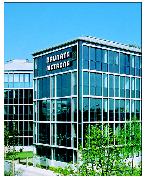
BRUNATA-METRONA Firmenzentrale in München
